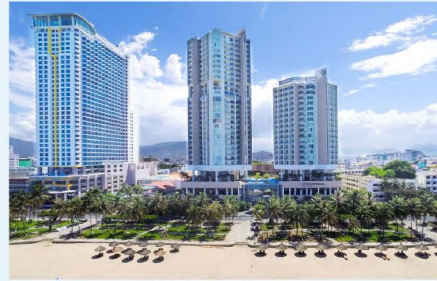
THE COSTA NHA TRANG | KHÁNH HÒA 17 thang máy 02 thang cuốn
