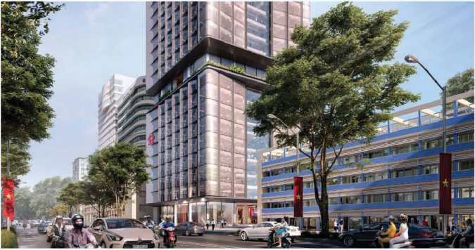
TECHCOMBANK | THÀNH PHỐ HỒ CHÍ MINH 15 thang máy
